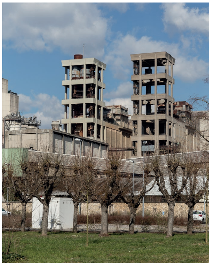
Denkmalgeschützte, stillgelegte Wärmetauschertürme Dyckerhoff Zementwerk Foto: Ansgar Koreng
