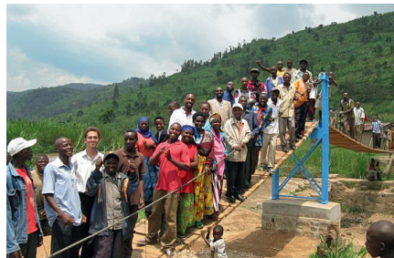
Die Kompetenzgruppe Brücken- und Hochbau führt jährlich ein Brückenbauseminar am Kigali Institute of Science and Technology (KIST) in Ruanda durch. Infolgedessen entstand diese 30 Meter spannende Seilbrücke über den Fluss Mukungwa. Sie ermöglicht den Bewohnern des Gakenke-Distriktes u.a. den Zugang zum Krankenhaus.
