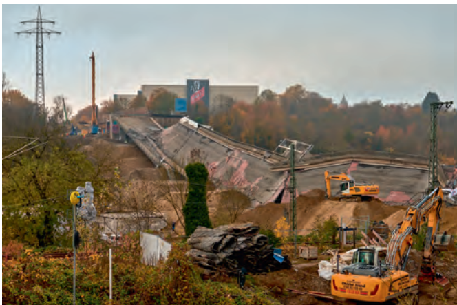
Die Salzbachtalbrücke von oben nach der Sprengung.
