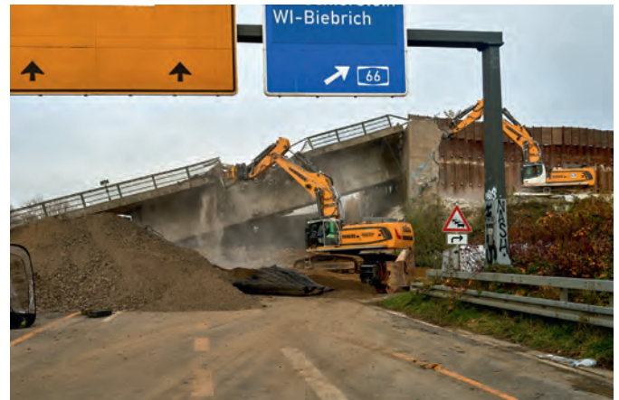
Nach der Sprengung der Brücke begannen die Aufräumarbeiten.
