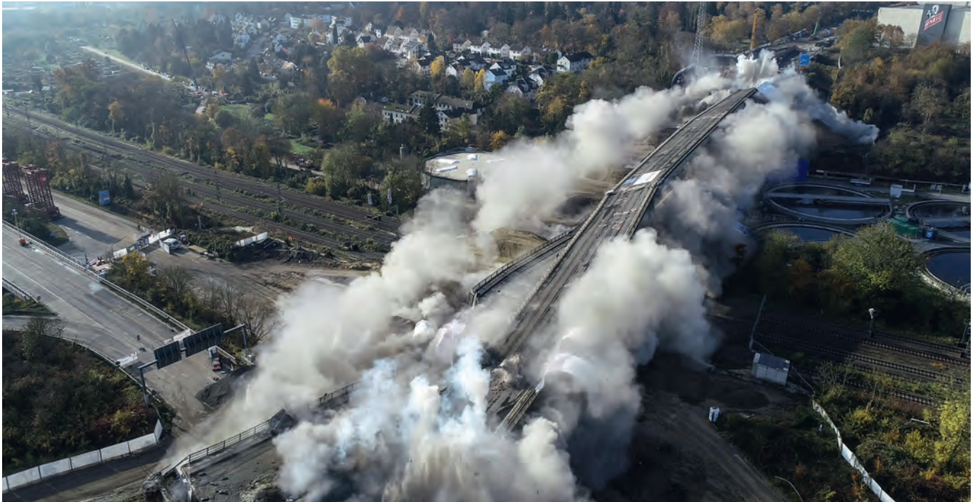
Die Salzbachtalbrücke von oben während der Sprengung.
