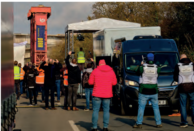
Zunächst fiel die (hier aus der Perspektive des Pressecampes vordere) Südbrücke in Fahrtrichtung Frankfurt, bevor zwei Sekunden später der nördliche Teil der Salzachtalbrücke auf den Südüberbau kippte.
