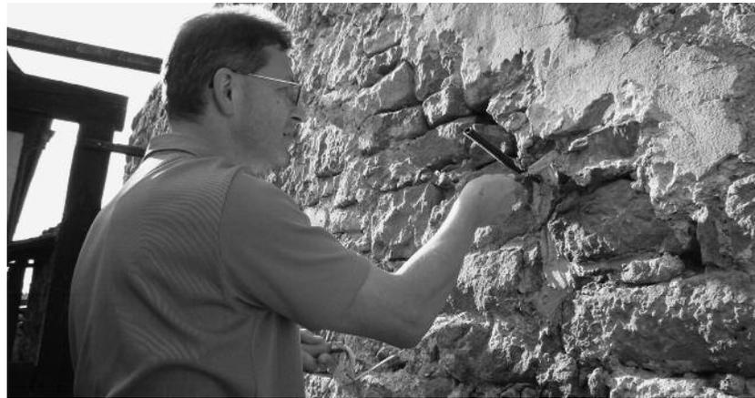
Im Seminarblock Mauerwerk lernt der Ingenieur, die Ingenieurin die Technik kennen, Risse oberflächlich zu schließen und in der Tiefe mit dünnflüssigem Mörtel zu verfüllen.
